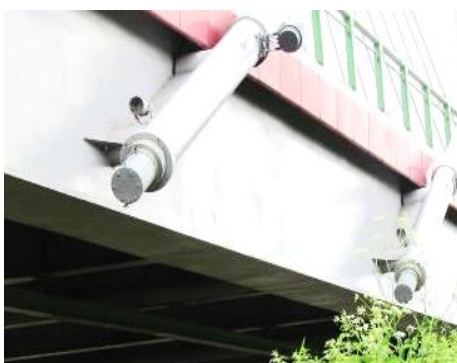
Rysunek 26 Most Brama Przemyska: widok zakotwienia wanty w stalowym dźwigarze oraz przykładowe wyniki pomiarów odkształceń na długości 20 metrów, pokazujące lokalne wzmocnienie dźwigara spowodowane obecnością zakotwienia (dzięki uprzejmości SHM System)
