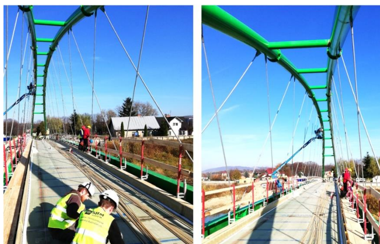
Rysunek 28 Instalacja światłowodowych czujników odkształceń i temperatur na długości 80-metrowego przęsła kładki dla pieszych w Nowym Sączu (dzięki uprzejmości SHM System)
